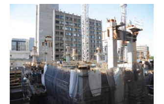
建設中の入院棟Ⅱ期
