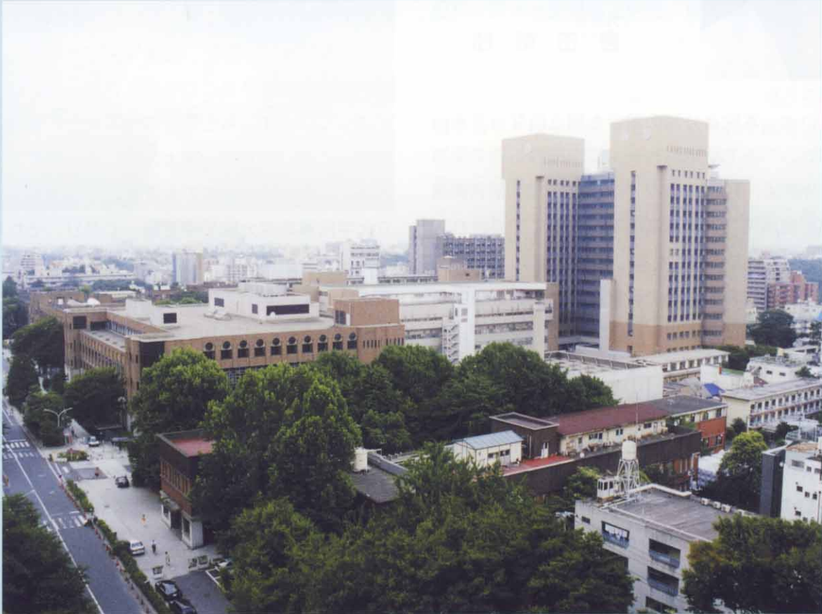
竣工間近い新病棟（手前は新外来病棟と南研究棟）
