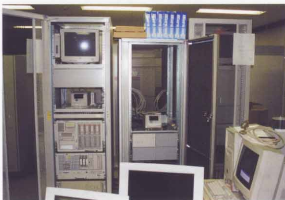
写真6 入院棟用のサーバーコンピュータを準備しているところ
