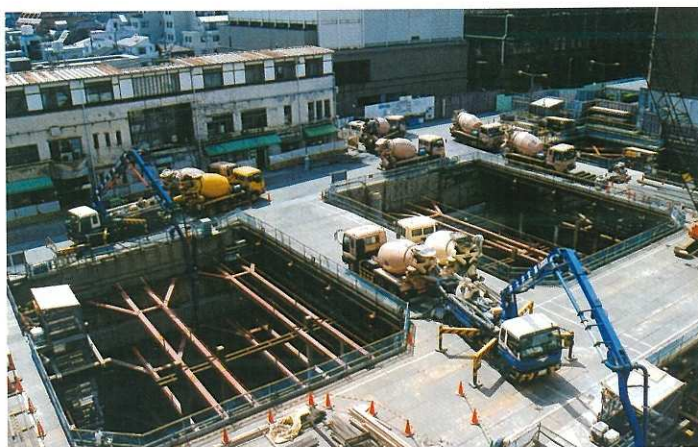
中央診療棟Ⅱ期工事 (H16年 4月)
