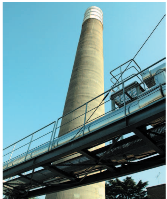
東大病院のボイラーの煙突。この下には病院のエネルギーセンターの一つがあります。
