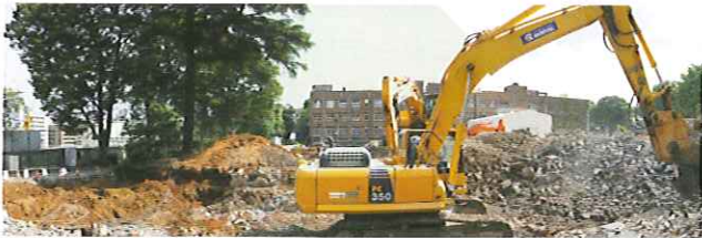
解体工事の様子（平成21年8月撮影）
