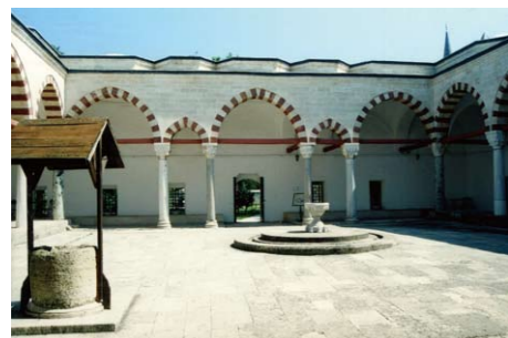
図10：中庭から医学校を見る
