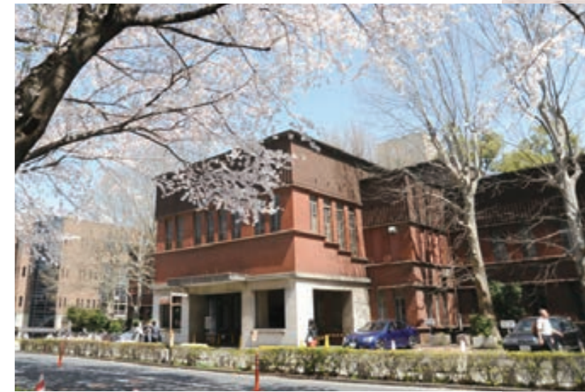
改修前の南研究棟
