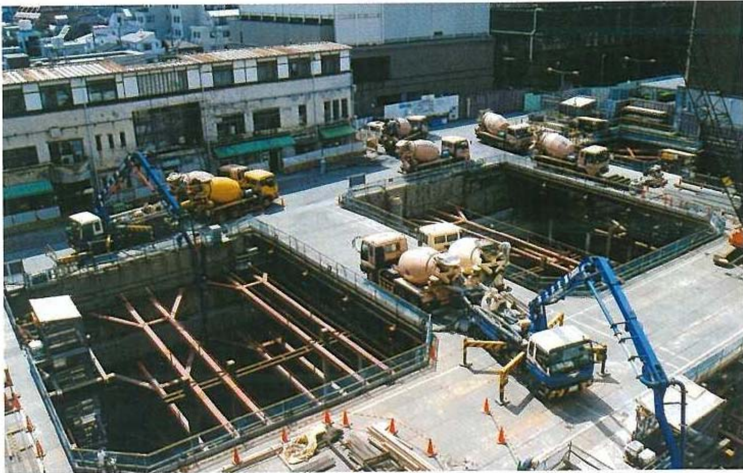
中央診療棟Ⅱ期工事 (H16年 4 月)
